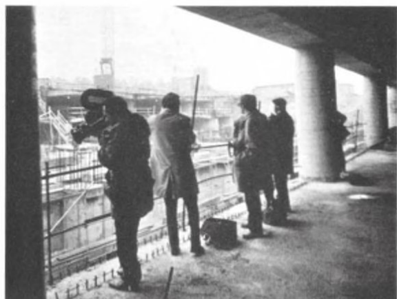
Blick von der Ankunftsebene des neuen Terminals auf den Rohbau des Tiefbahnhofs und die Tiefgarage, die 6000 Autos Platz bietet. Foto: Milan Skaryd
