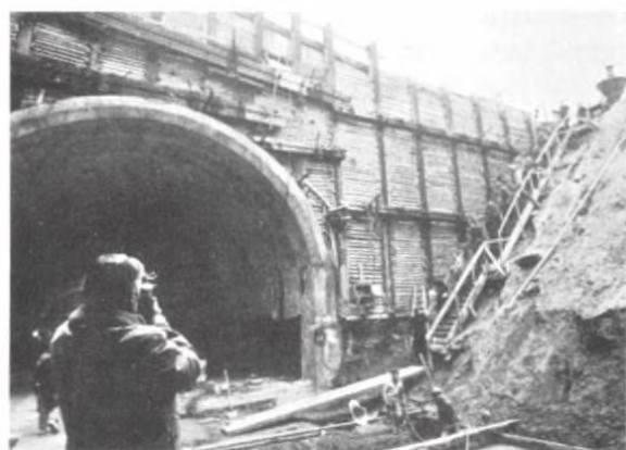
Ohne Störung des Autobahnverkehrs wurde der Tunnel für die Flughafenbahn gebaut. Foto: Milan Skaryd
