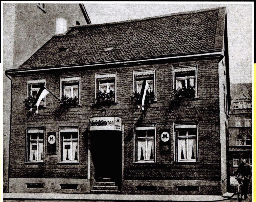
Das „Schieferhäuschen“ an der Kuckelke vernichtete der Krieg
