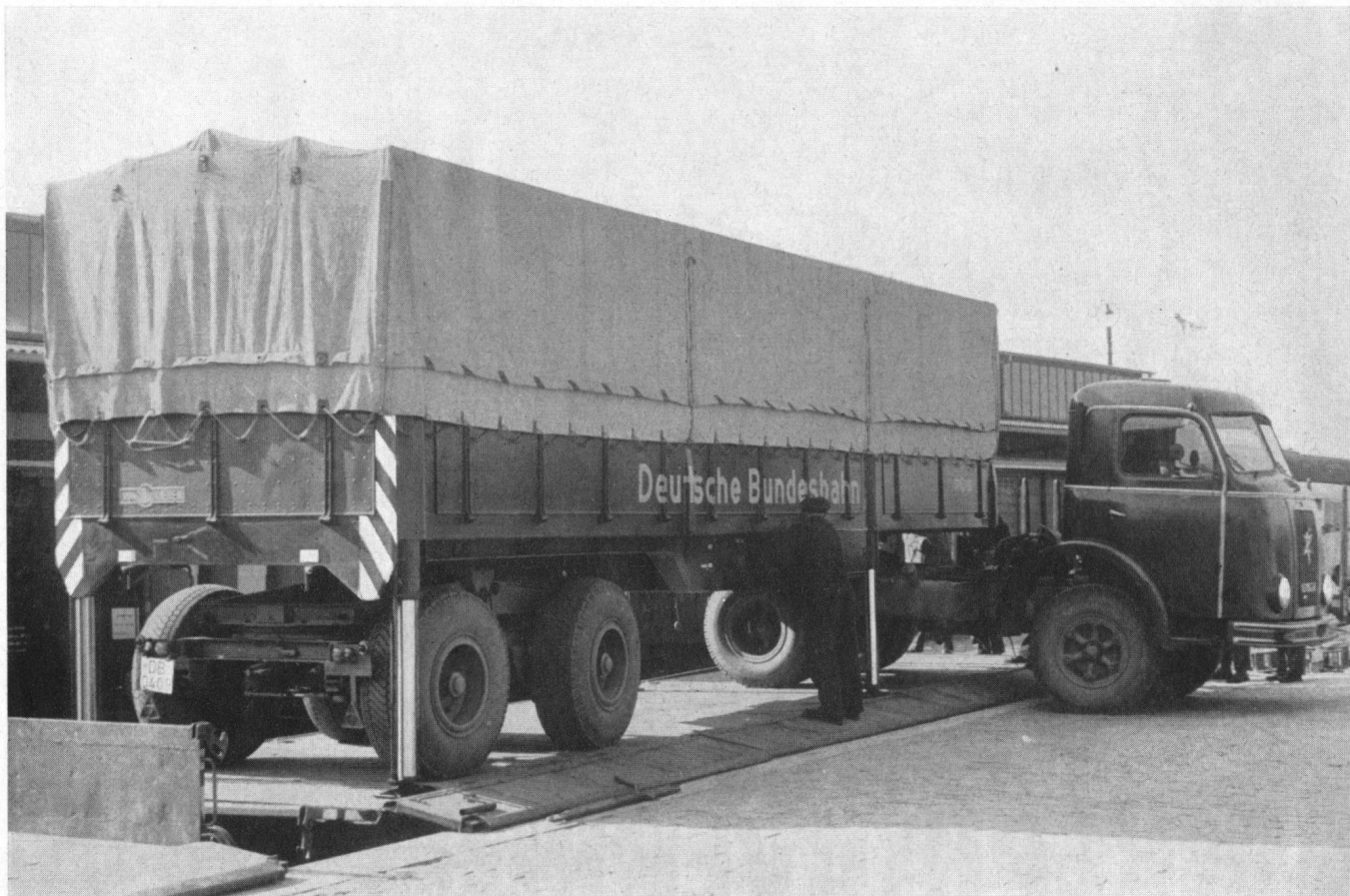
Huckepacksattelfahrzeug fährt in Verladestellung auf Rmms-Wagen von einer Seitenrampe
