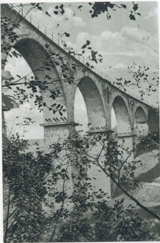
Bad Bibra, Schrecktalbrücke
