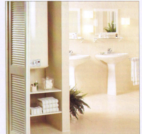
150 Liter Wandspeicher – im Badezimmerschrank eingebaut.
