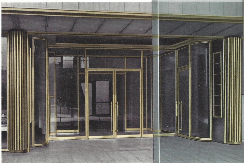
Agrippina-Versicherung, Mannheim M 7/16, Architekt Emil Serini BDA., Mannheim
