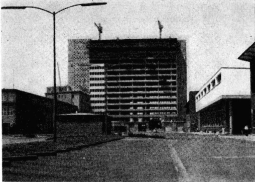
2 Kletter-Turmdrehkrane „SCHWING“ KTK 25 im Einsatz
