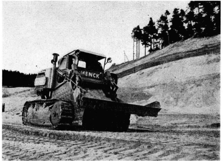
MENCK-Schürfkübelraupe SR 53 im Einsatz (Werkfoto M & H)
