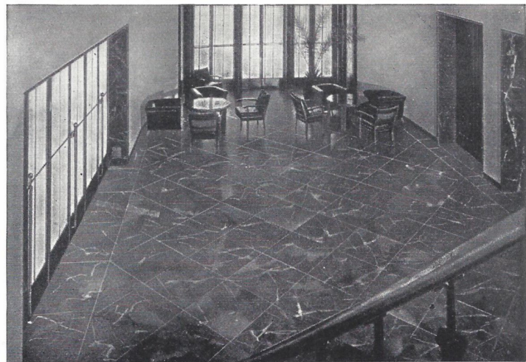
In der Diele muß der Fußboden unempfindlich sein und sich leicht reinigen lassen. Marmor entspricht diesen Anforderungen.
