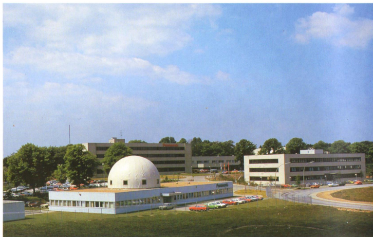
Zentrale Panasonic Deutschland GmbH, Hamburg
