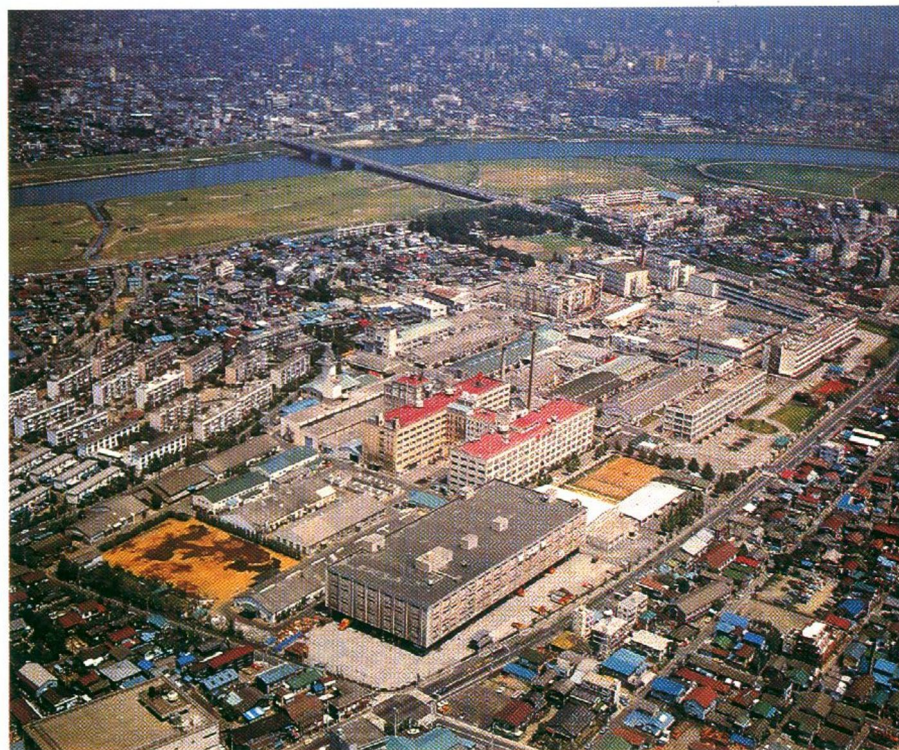
Toshiba Fukaya Werke. Fertigung und Entwicklung von Bildröhren und Farbfernsehgeräten.
