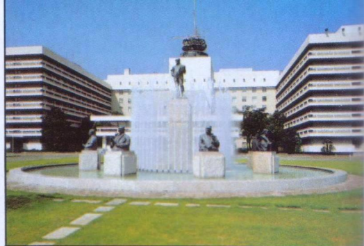
Haupt- und Forschungslaboratorium Matsushita Electric, Osaka.
