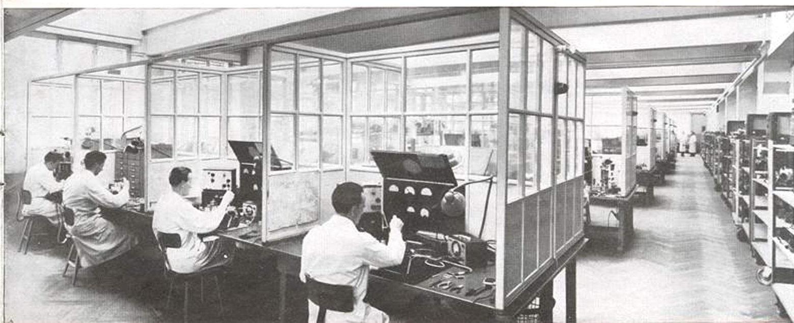
Die elektrische Schlußprüfung erfolgt in Einzelkabinen
