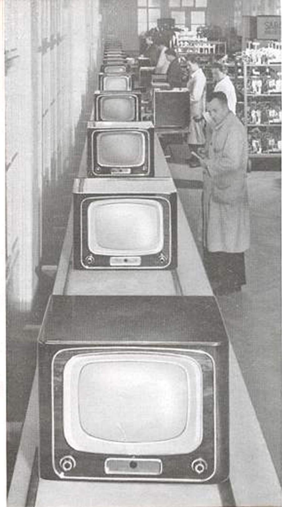
▲ Hier rollen die Fernseh-Empfänger in die Schlußprüfungskabinen
