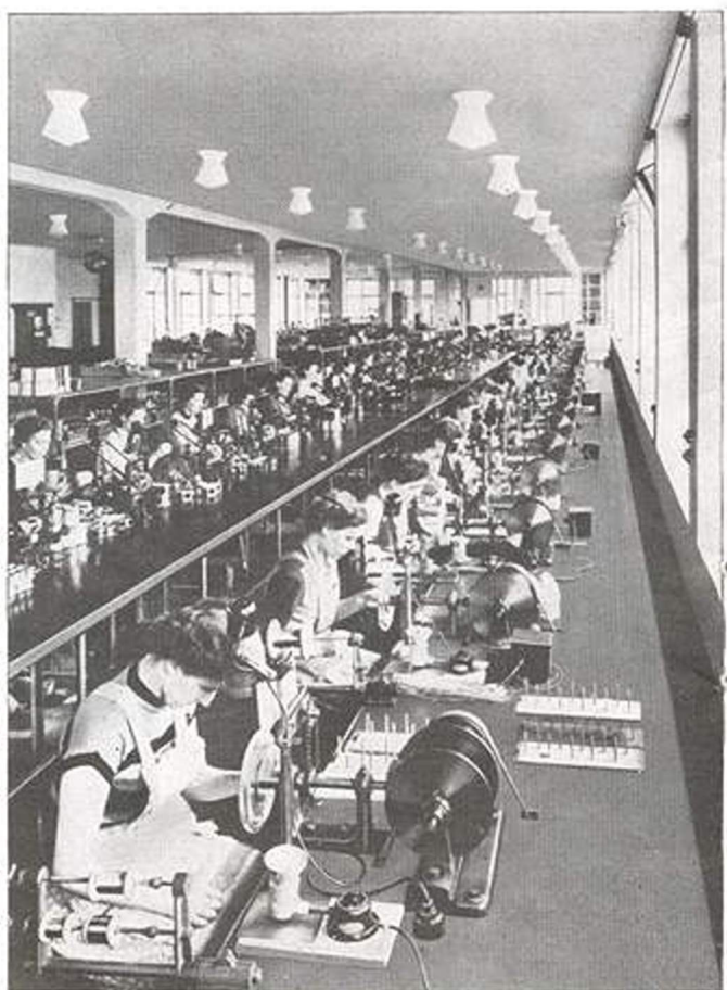
Hier werden die neuartigen SABA-Mikrofilter gewickelt
