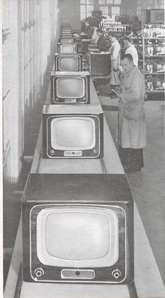
▲ Hier rollen die Fernseh-Empfänger in die Schlußprüfungskabinen
