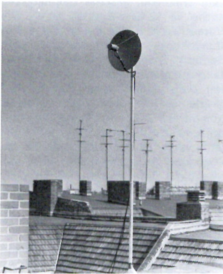
Abbildung 4 Direkt im Brennpunkt des Parabolspiegels ist der GHz-Mischkopf angeordnet. Im Bild sieht man den Mischer und links daneben den UHF-Vorverstärker, von dem das Empfangssignal über Kabel dem nachgeschalteten UHF-Verstärker in der Zentrale unter dem Hausdach zugeführt wird. Der Abschirmdeckel des Gehäuses wurde für die Aufnahme entfernt. Nicht sichtbar sind der Hornstrahler und der Hohlleiter, die als Bandpaß ausgeführt sind. Die Auskopplung zur Mischstufe erfolgt am Ende des Hohlleiters (Philips-Anlage).
