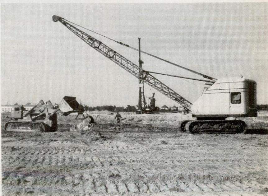
Dampframmen, Bagger und Planierungsmaschinen begannen im Oktober 1956 auf dem weiträumigen Gelände in Bremen-Hemelingen mit der Arbeit
