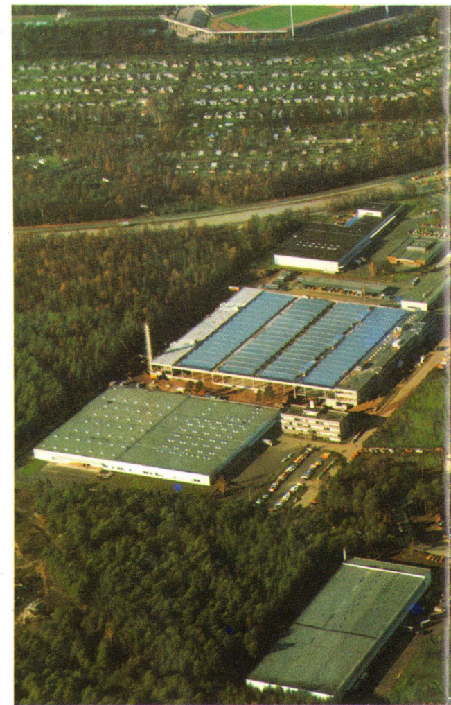
Das Grundig Fabrikations-Zentrum Nürnberg-Langwasser ist hier haben wir Europas modernste Video-Fertigung auf die
