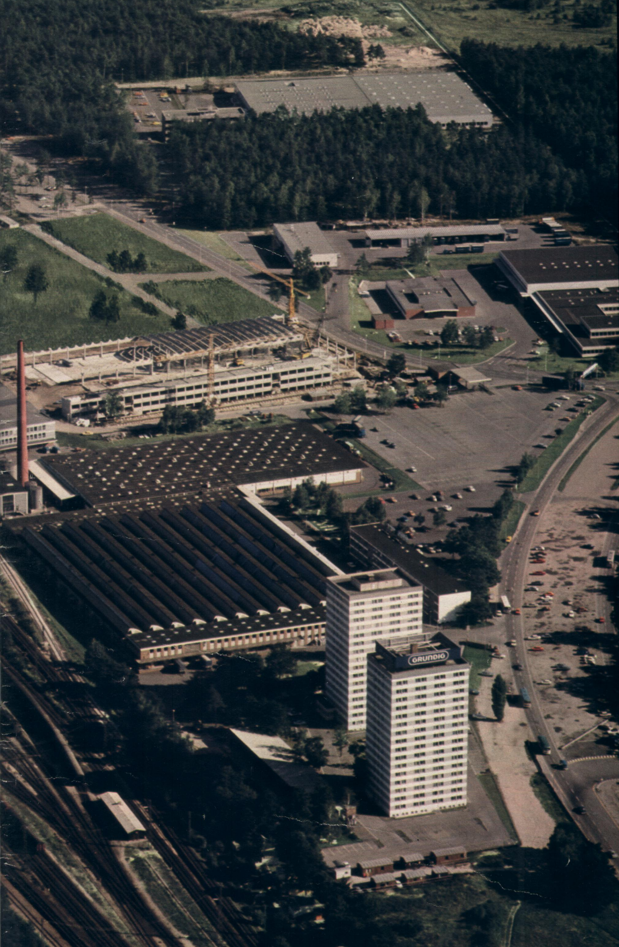
GRUNDIG Fabrikationszentrum Nürnberg
