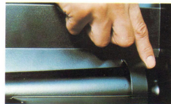
Beim Übergang in den Sammelkanal treten Strömungsgeschwindigkeiten von über 100 km/h auf.
