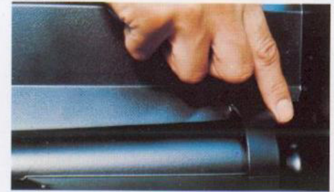
Beim Übergang in den Sammelkanal treten Strömungsgeschwindigkeiten von über 100 km/h auf.
