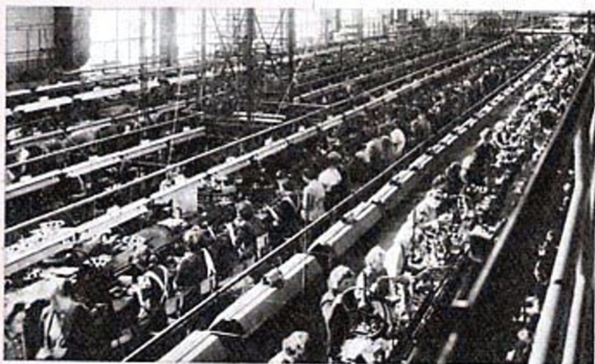
Blick in die „Amsele“, in der Fließband neben Fließband läuft. Viele tausend Blaupunkt-Geräte werden hier täglich gefertigt.
