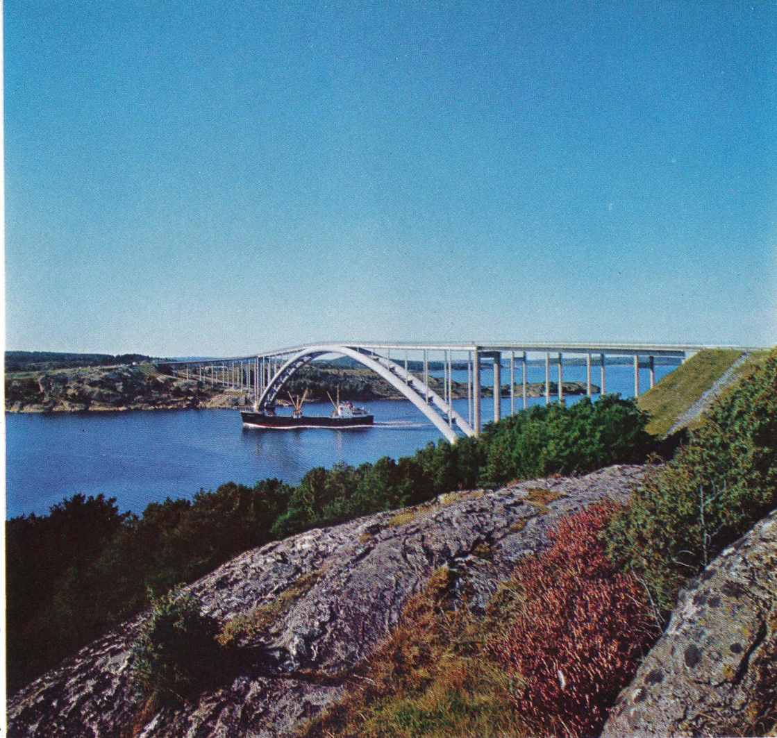
Tjörnbrö bridge. Photo: T. Skår
