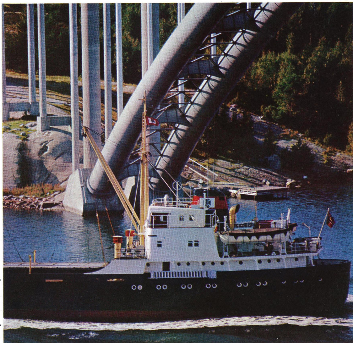
Tjörnbrö bridge. Photo: T. Skår
